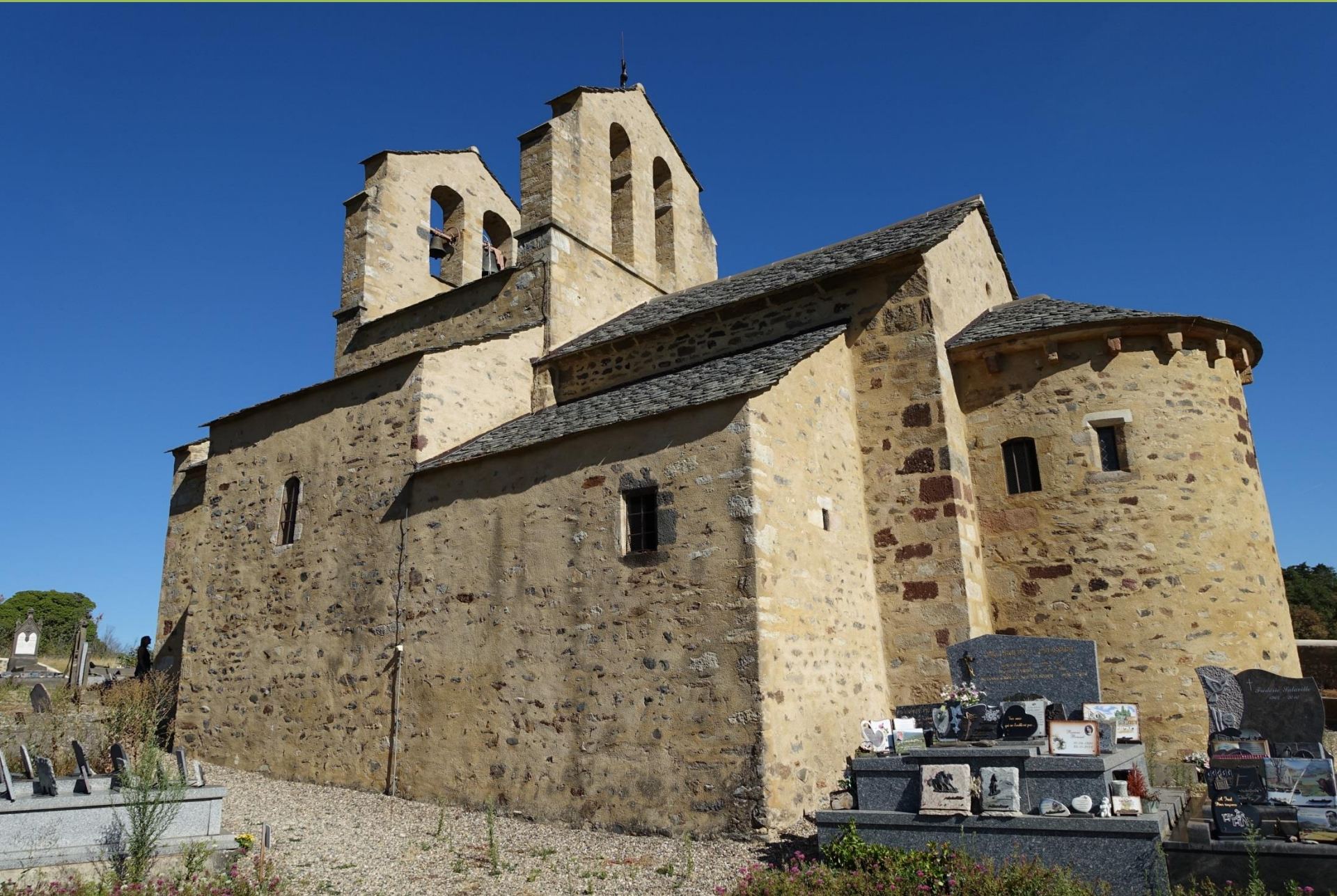
Chevet et façade sud
